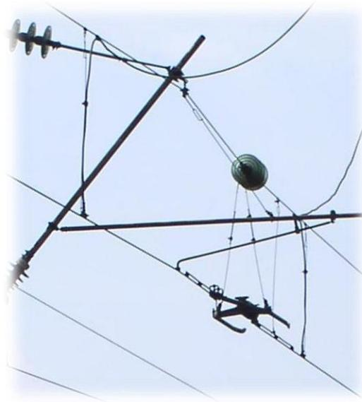
Fig. 21 : Exemple d'isolateur de section (à cet endroit,  $V = 60 \text{ km/h}$ )
