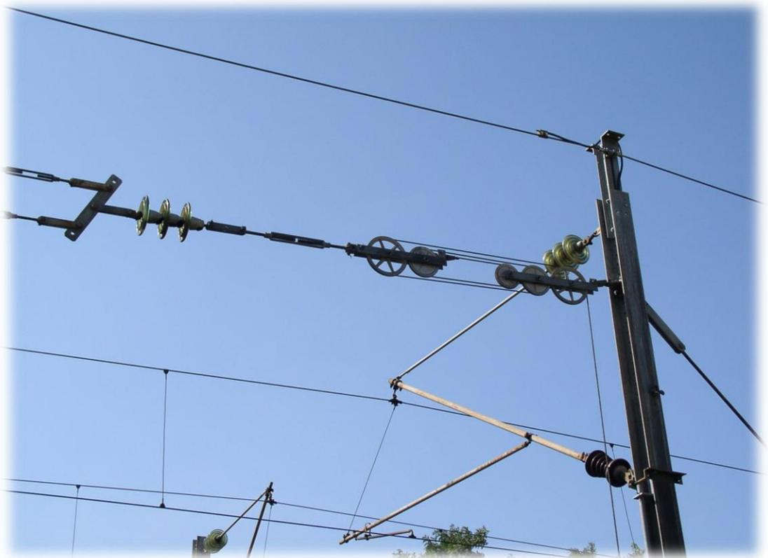
*Fig. 18 : Appareil tendeur à moufles avec poulies à axes parallèles*
